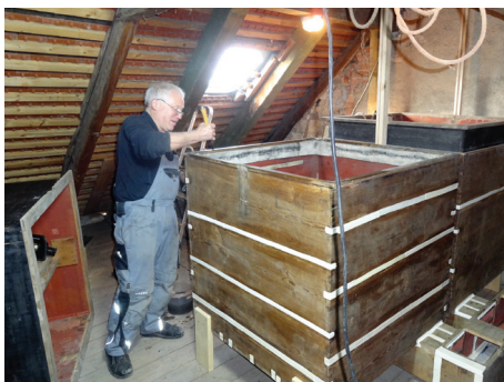
Orgelbaumeister Georg Wünnig bei den Arbeiten an der Balganlage der Orgel (Foto: Christoph Steinert)
