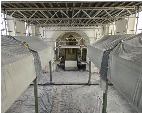
Ende Februar: das Gerüst steht in der Kirche Beucha
